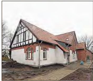
Saniert: In der alten Schule ist auch eine barrierefreie Wohnung entstanden. Bild: rast
